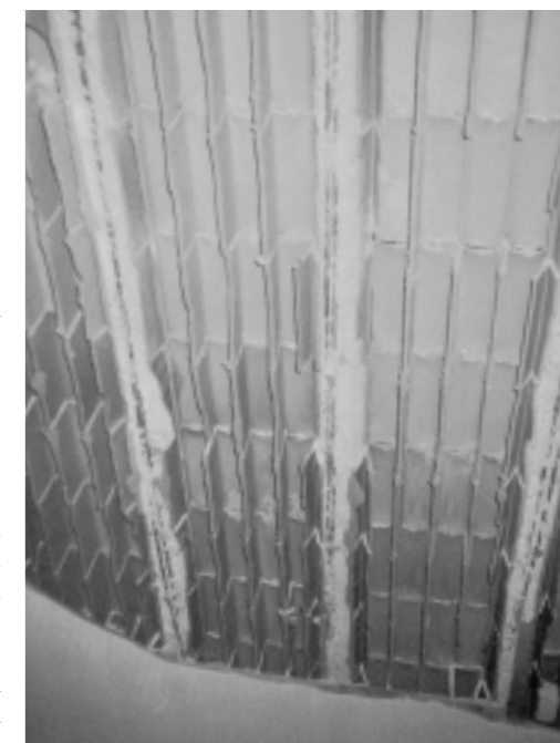
al ritiro dell'intonaco cementizio, all'eccessiva luce dei tavelloni (2 metri) e alle forti e repentine escursioni termiche dovute al discontinuo riscaldamento ad aria (sono visibili le bocchette di immissione).
