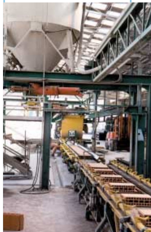
Fig. 7 - I blocchi di laterizio pronti per l'assemblaggio. The clay blocks ready for assembly.
