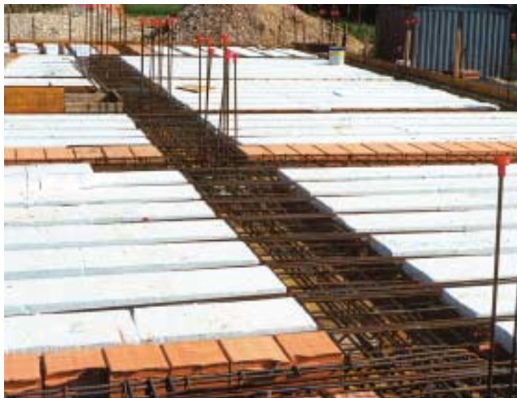
Fig. 15 - Il solaio pronto per il getto di completamento. The floor ready for the completion.
