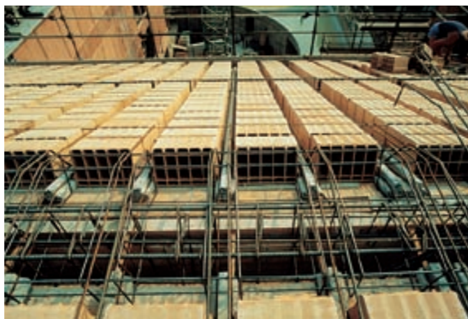
Solaio a travetti e blocchi di laterizio pronto per il getto di completamento.
