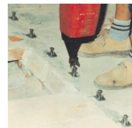
Intervento di ristrutturazione di un solaio acciaio-laterizio con connettori a chiodatura pneumatica (per gentile concessione dell'archivio Tecnaria S.p.A., Buzuno, Vicenza).
