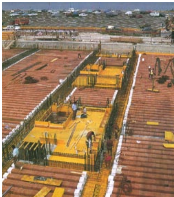
Fase costruttiva di uno dei sei orizzontamenti.
