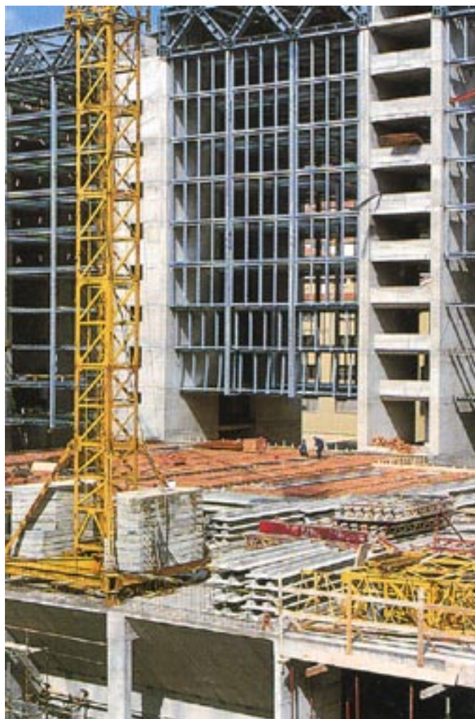
Una fase della posa delle lastre e dei blocchi in laterizio.
