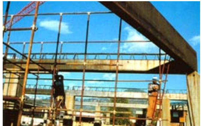
Travi metalliche con pre-casseratura sui fianchi.
