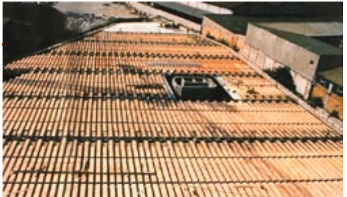
Vista dei campi di solaio prima del getto.
