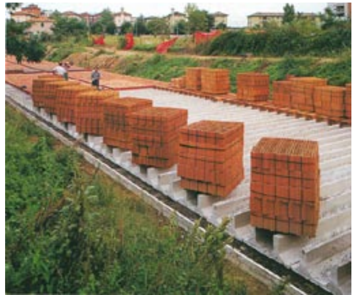
Vista dei blocchi di laterizio sul solaio a lastre nervate in attesa di essere posizionati.
