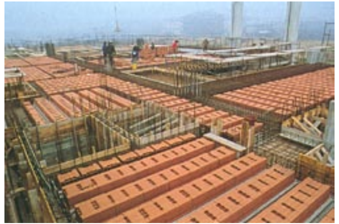
Disposizione delle lastre e dei blocchi di completamento in laterizio prima del getto.
