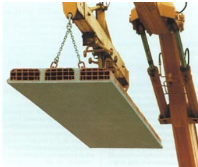
Pannello prefabbricato largo cm 120 costituito da tre filari di blocchi portanti in laterizio e da una soola inferiore precompressa ad elevato grado di finitura.
