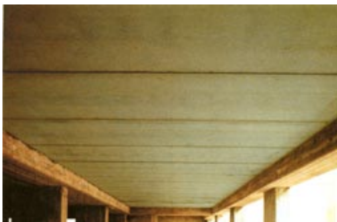
Vista dell'intradosso: i giunti d'affiancamento dei pannelli richiedono una semplice rasatura.
