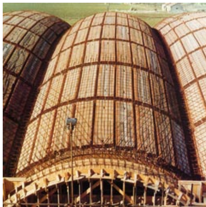
Una vista delle fasi di posa dei pannelli in laterocemento costituenti le "onde" di m 7x40: in evidenza le armature diagonali e incrociate della soletta in corrispondenza dei timpani frontali.
