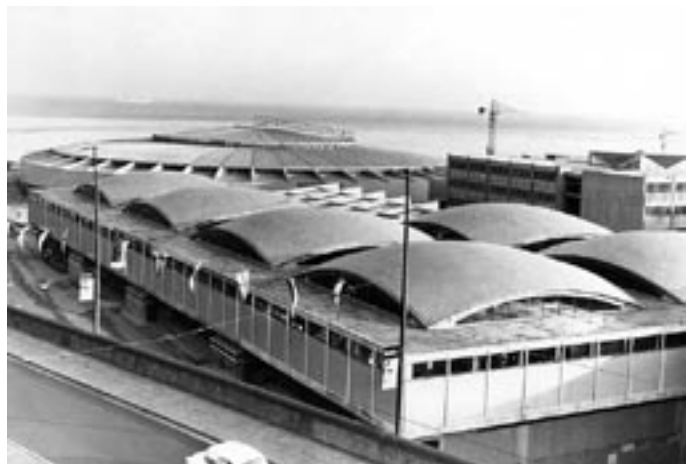
Padiglioni della Fiera Internazionale di Genova: vista del complesso di otto volte a vela su pianta di m 28x28, distanziate da corsie piane appese ai bordi delle volte.
