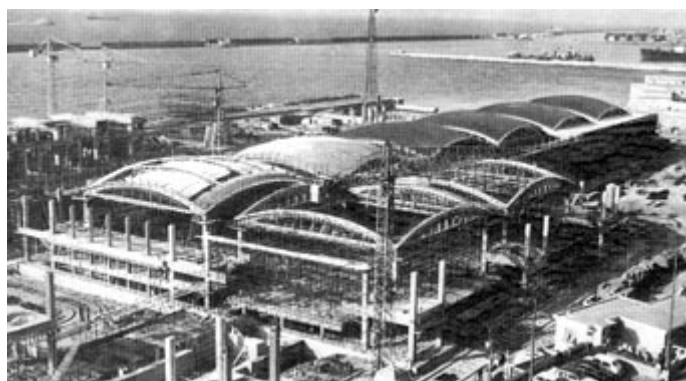
Una fase costruttiva delle volte a vela: la predisposizione e getto degli arconi di bordo e la centinatura per la posa del laterizio.
