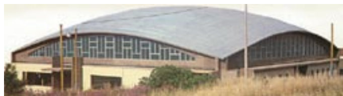
Vista della volta finita e completa del manto di copertura. Le lunette finestrate evidenziano gli appoggi strutturali della grande copertura sui soli vertici del perimetro.
