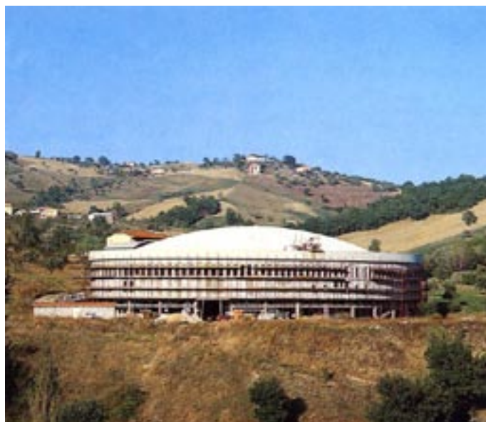
Una vista, in fase di ultimazione, della grande cupola ellittica di soli 24 cm di spessore e diametro massimo di 63 m.
