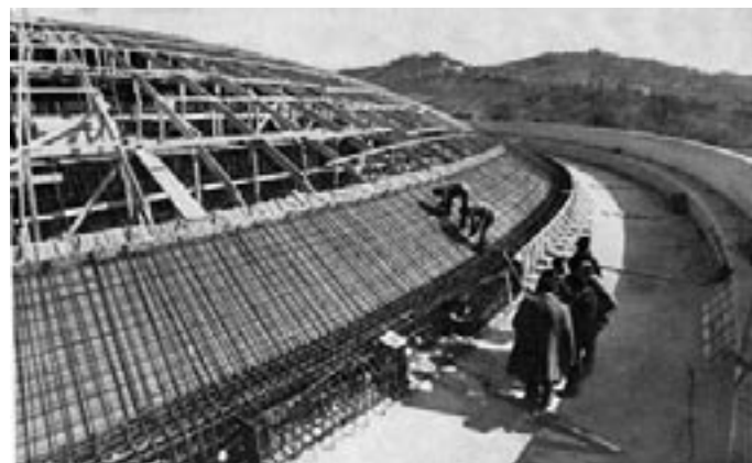
Una fase costruttiva della cupola: le centine radiali e l'armatura per la fascia laterale in getto di calcestruzzo; nell'anello d'imposta reggisplinta sono predisposti i cavi di precompressione.
