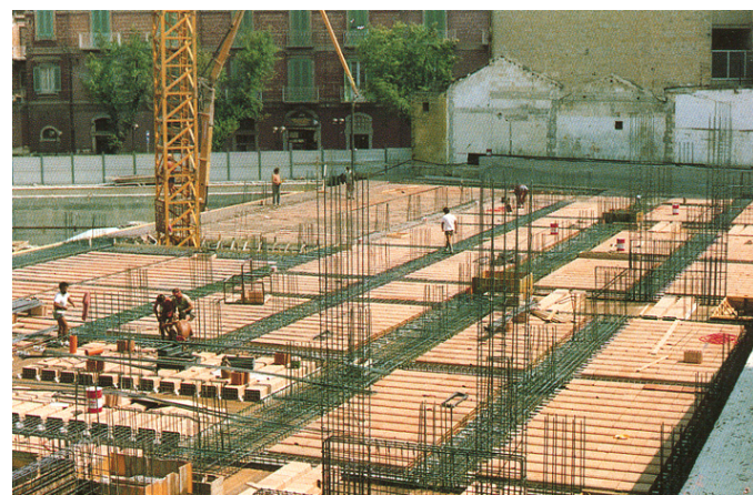
Campate in travetti precompressi per i piani di elevazione, evidente l'adattabilità dei travetti alle articolazioni planimetriche
