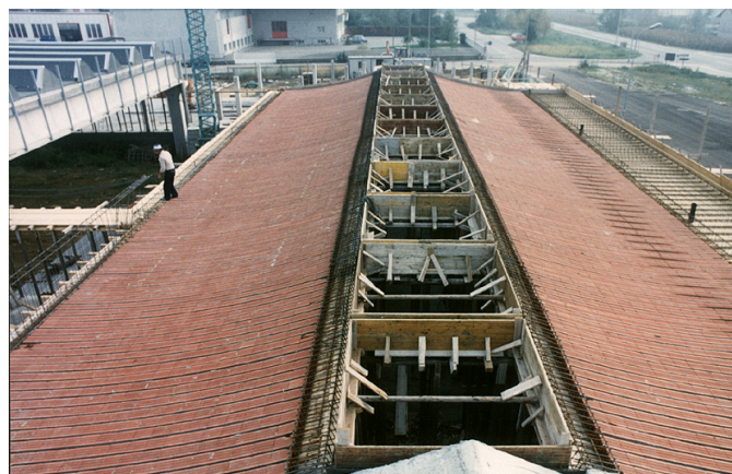
Doppia falda tensoinflessa in travetti curvi in laterocemento
