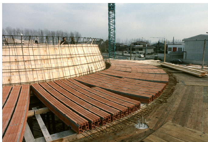
Raccordo circolare, in travetti curvi in laterizio, alla cupola centrale
