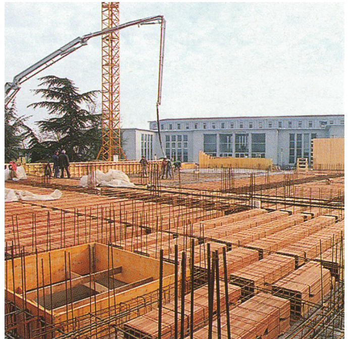
Orizzontamento con travetti precompressi abbinati e blocchi in laterizio nella configurazione bi-blocco
